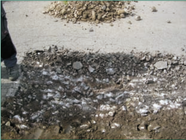
Bituminösen Aufbau zerkleinern, steinigen Unterbau brechen und mit anstehendem Boden mischen.
