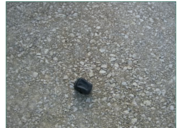
Nach Herstellung von Planum und Verdichtung (Abmessungen Vergleichsobjekt 7 x 12 cm)
