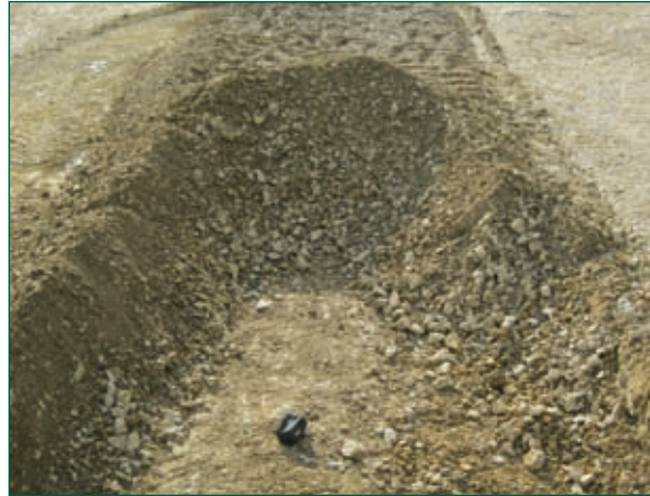
Aus der anstehenden Hoffläche, Material 0/56 mm, Verfüllmaterial für einen Rohrgraben herstellen.
